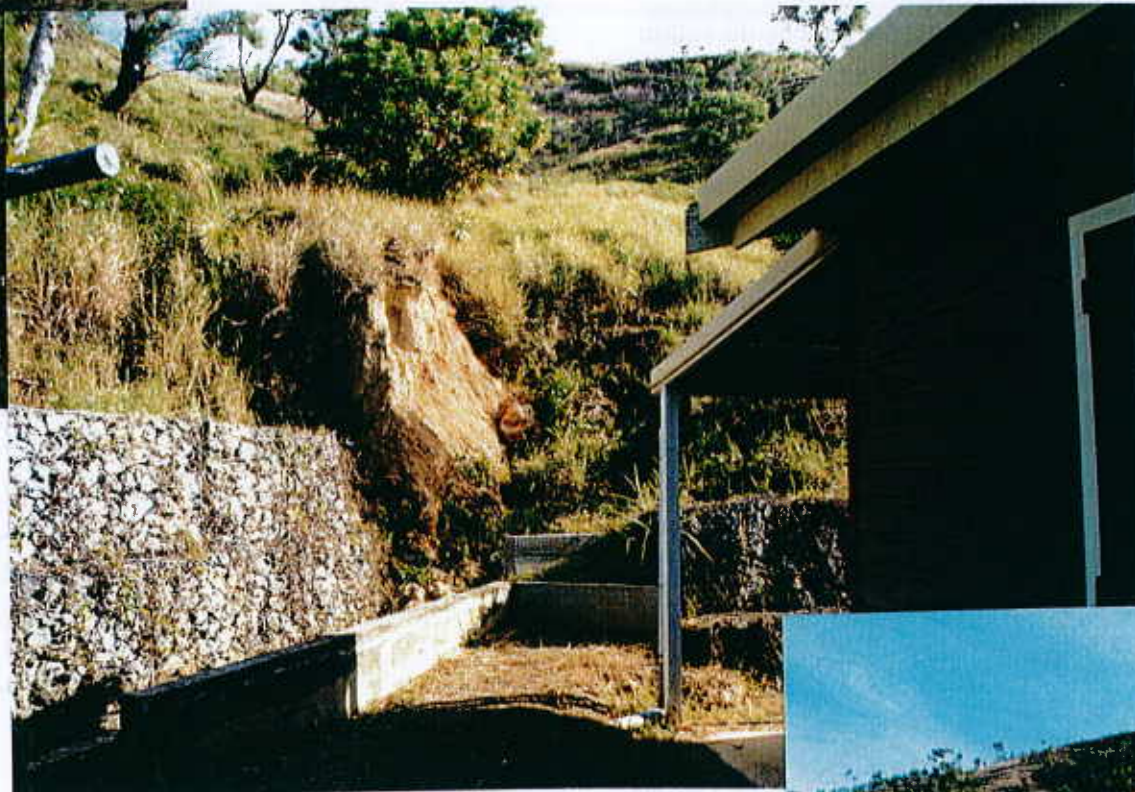
Photo 2 : Bourrelet frontal et protections en gabions
